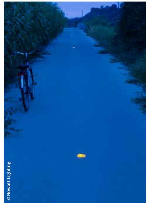
Les pistes cyclables, de plus en plus utilisées, font également partie des lieux où l'éclairage solaire est très adapté. Nowatt Lighting a déployé 600 plots autour de l'étang de Thau.
